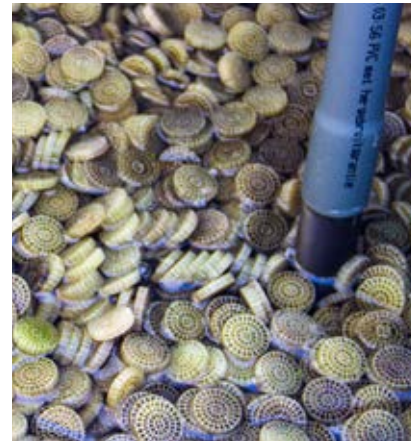
In de MBBR vormt zich op de schijfjes een biofilm met bacteriën, die de nitraten uit de spuiroom omzetten in vluchtig stikstof.
