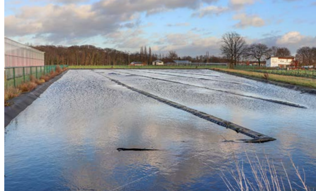
Een waterbassin met een zeil dat net onder water ligt. Door dat zeil warmt het water sneller op, wat ook de verdamping versnelt en veel vogels aantrekt.
